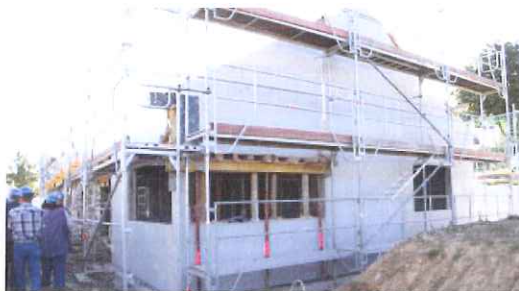
La charpente du local sera installée la semaine prochaine.
