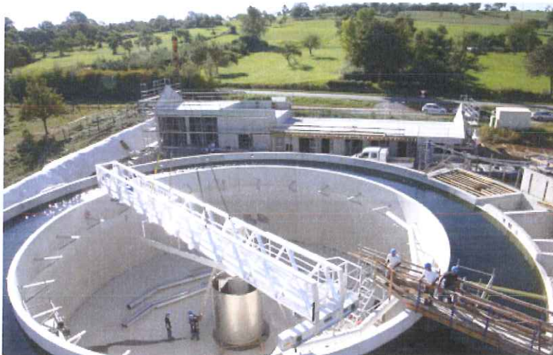
La grue a déposé le pont racleur sur le clarificateur. PHOTOS DNA - MARIE GERHARDY
